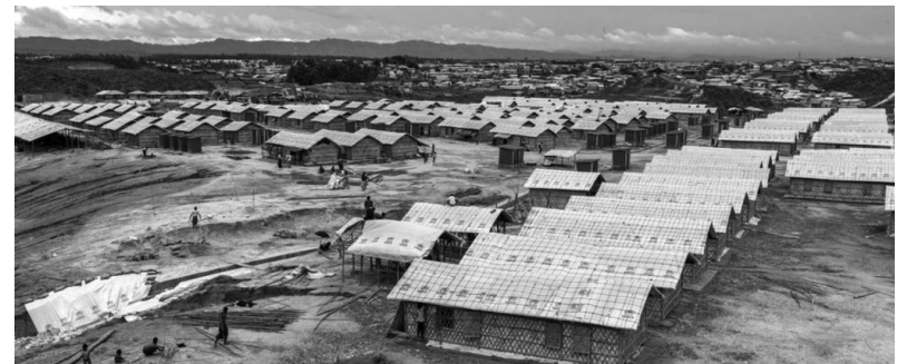
多くのロヒンギャが逃れるバングラデシュのコックスバザールでは、モンスーンによる地滑りや洪水のリスクを避けるため、低地に新たなシェルターが建設された (UNHCR/Adam Dean)
